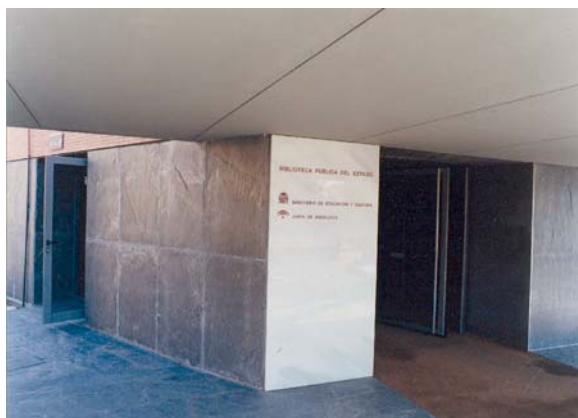
Biblioteca Pública del Estado. Sevilla.
