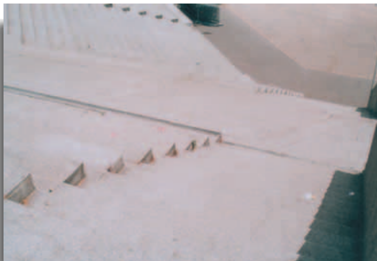
Detalle de escalinata carente de contraste visual, barandilla y pasamanos.
