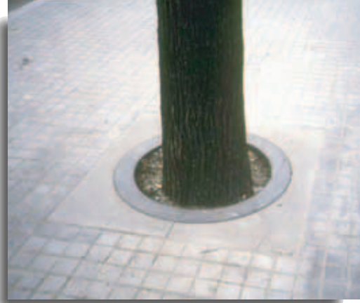
Fig.5 y 6. La delimitación del espacio para los árboles presenta su complejidad. Una solución como la que muestran las fotografías permite adecuarse al crecimiento del árbol, resolver correctamente la entrega entre el pavimento de la acera y las piezas de hormigón que delimitan el alcorque, mientras que los círculos concéntricos de fundición son resistentes e indeformables.
