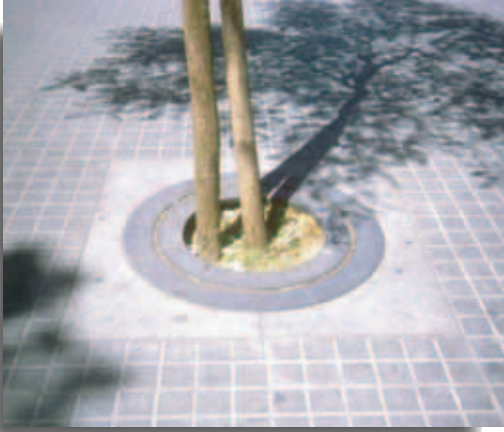
Fig.5 y 6. La delimitación del espacio para los árboles presenta su complejidad. Una solución como la que muestran las fotografías permite adecuarse al crecimiento del árbol, resolver correctamente la entrega entre el pavimento de la acera y las piezas de hormigón que delimitan el alcorque, mientras que los círculos concéntricos de fundición son resistentes e indeformables.
