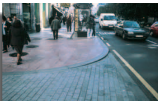
Fig. 4. Ejemplo de utilización de pavimentos con textura, color y forma diferenciados para marcar el paso ocasional de vehículos.
