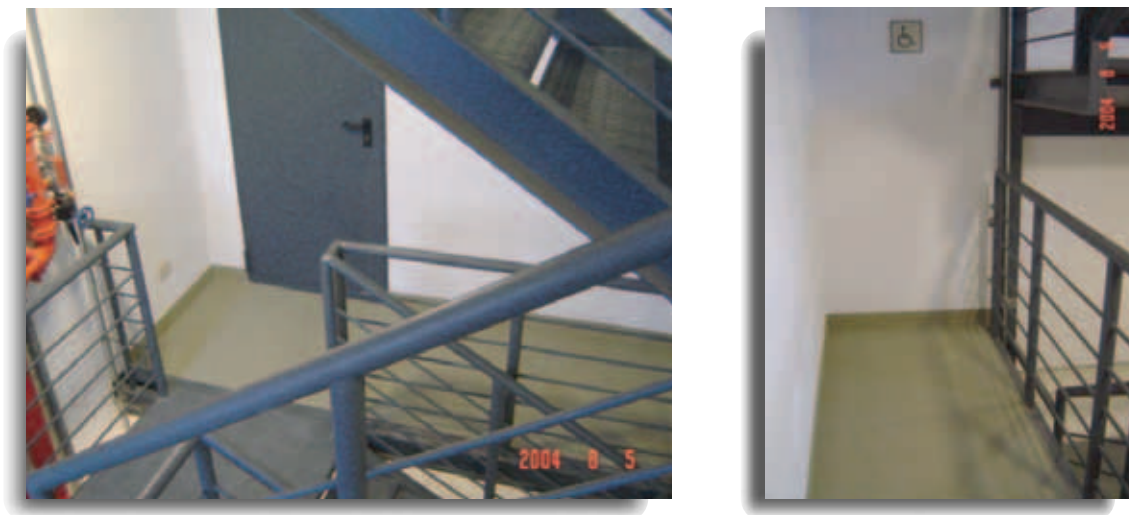
Fig 5 y 6. Sede del Banco Interamericano de Desarrollo. Montevideo. Rehabilitación 2004. La escalera de emergencia se encuentra en un recinto cerrado y presurizado para evitar la entrada de humo. El espacio donde puede ubicarse una persona con discapacidad no interfiere el recorrido de evacuación. La persona puede descender a su ritmo o ser evacuada desde este recinto seguro.
