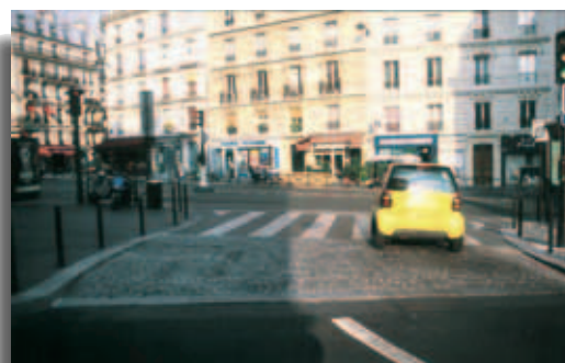
Fig. 11. Ejemplo de cruce con calzada sobreelevada.
