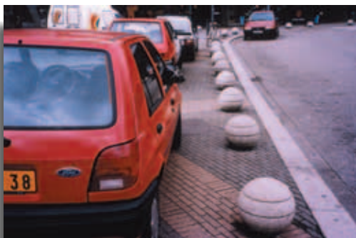
Bola de granito inadecuada.
