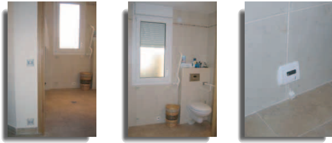
Fig. 30, 31 y 32. Apartamentos para personas con gran discapacidad del Centro Dato, Madrid. Las funciones en materia de seguridad pueden ajustarse a necesidades específicas, como detectar caídas (sensores de presencia a dos niveles que actúan coordinadamente) o salidas incontroladas de agua (grifos abiertos en duchas, fugas, etc.).
