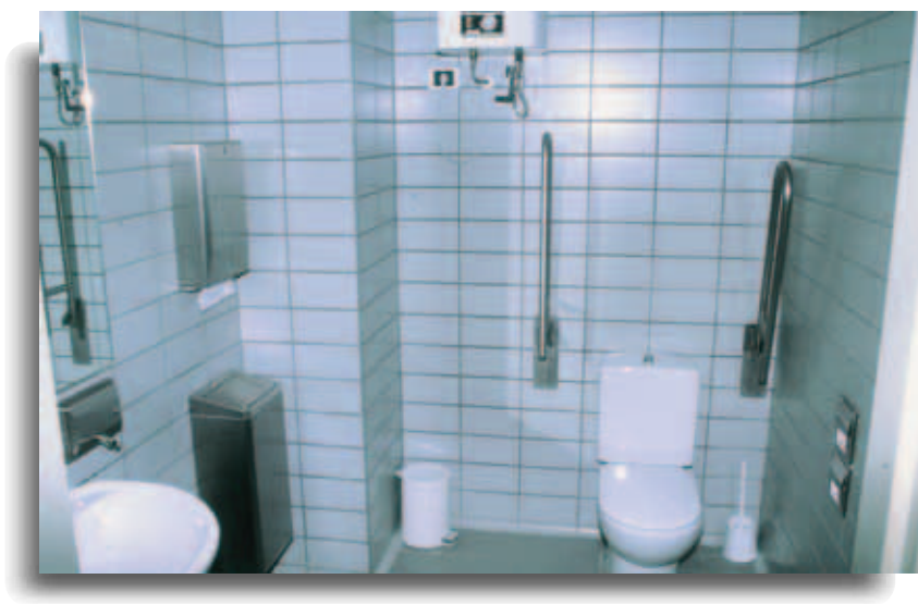
Fig. 28. Ejemplo de aseo adaptado diferenciado. Palacio Regional, Oviedo.
