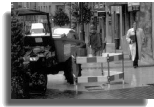
Otro tipo de protección para trabajos relacionados con registros urbanos.
