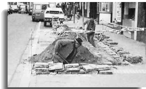
Protección inadecuada de obras.
