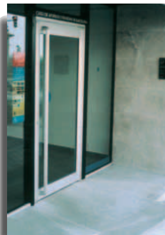
Fig. 17. Ejemplo de eliminación de escalón de entrada.
