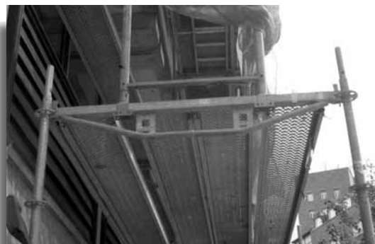
Otro ejemplo de viga en andamio multidireccional.
