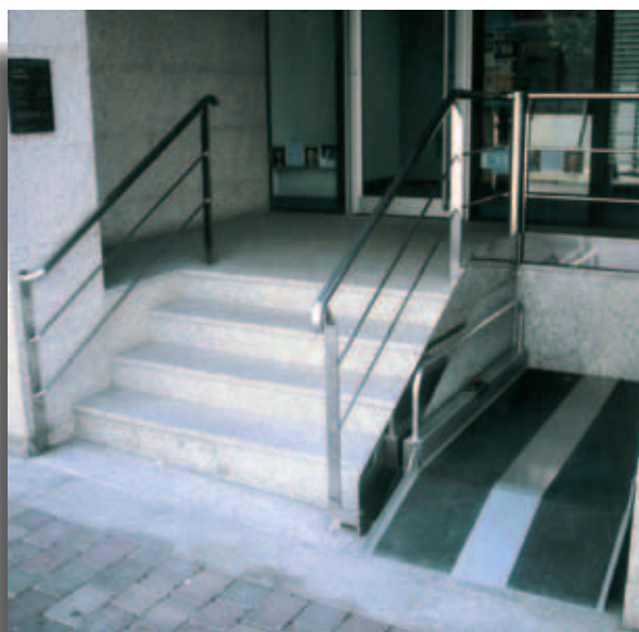
Fig. 30. Ejemplo de plataforma elevadora mecánica utilizada para salvar una escalera de acceso.
