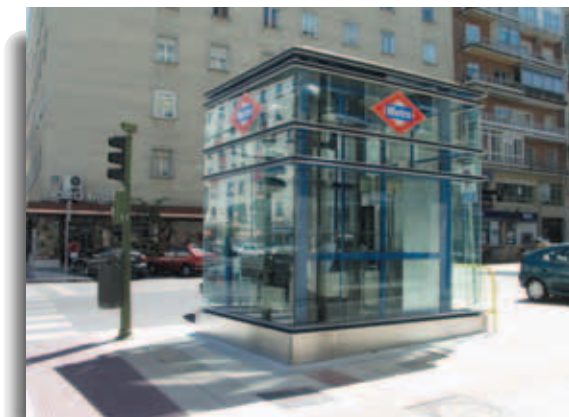
Ascensor del metro de Madrid.
