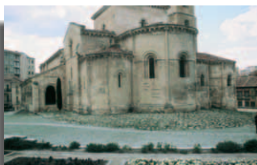
Fig. 6. Intervención reciente en torno a un monumento con el pavimento como elemento orientador.
