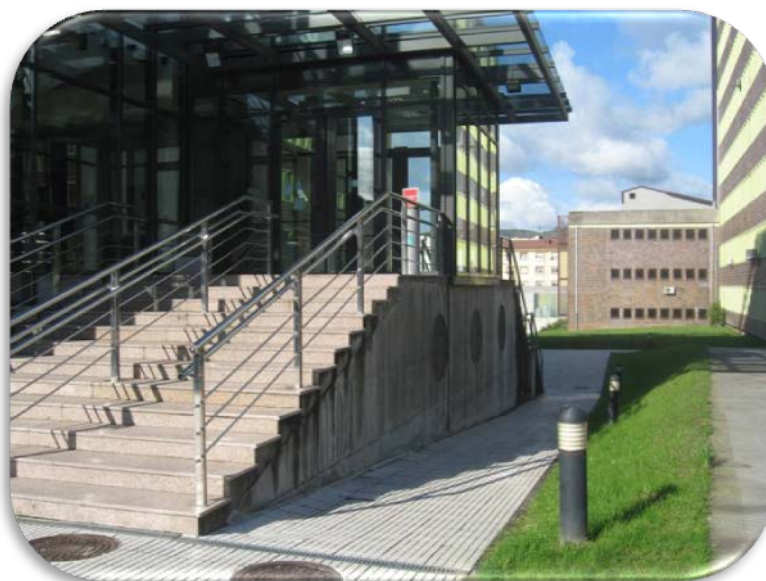
Imagen 6. Escaleras de acceso a la puerta principal.
