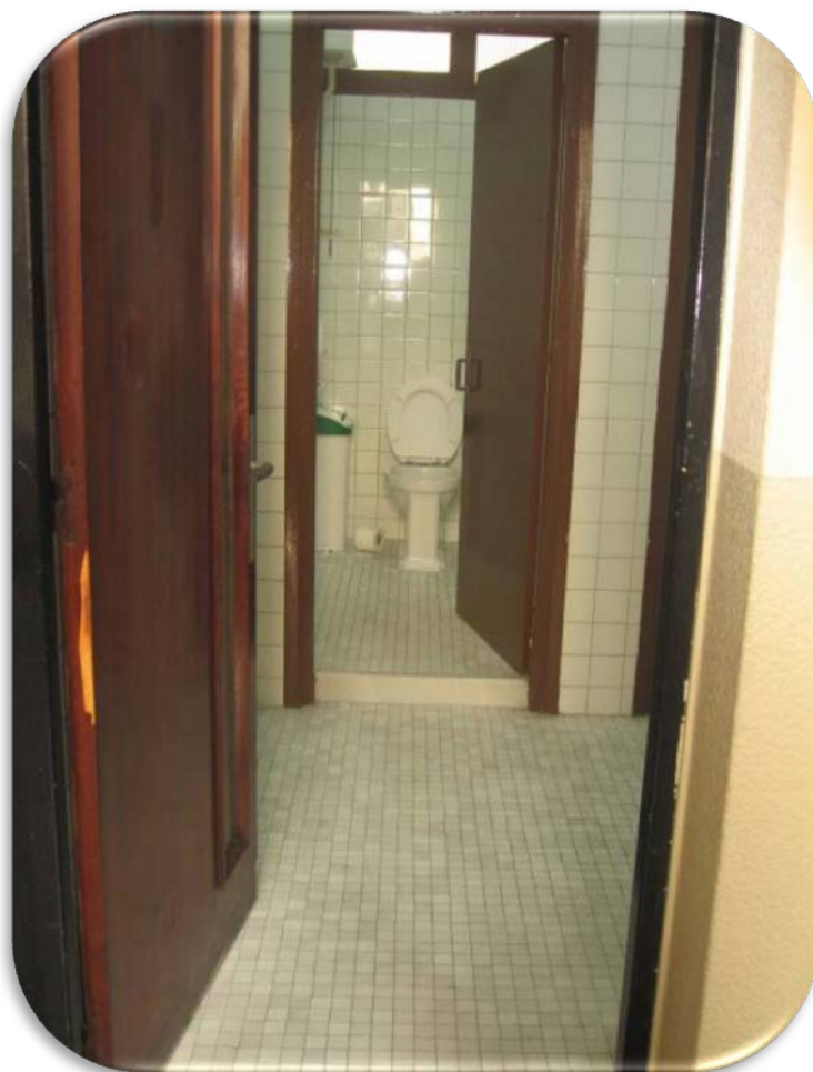
Imagen 5. Entrada a un aseo.
