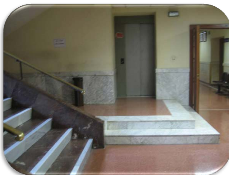
Imagen 1. Salida de ascensor.
