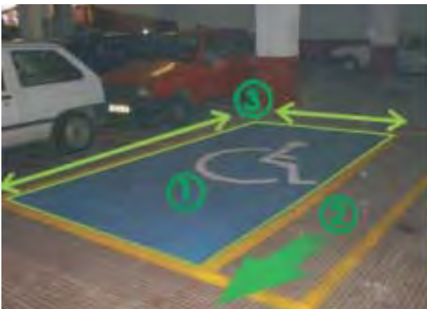
Señalización horizontal de plaza de aparcamiento reservada
