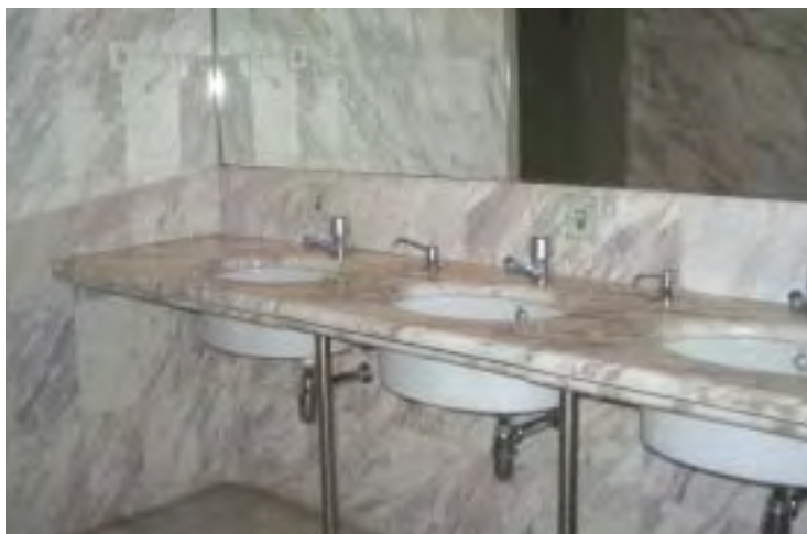
Lavabos que permiten la aproximación frontal de una persona en silla de ruedas.
