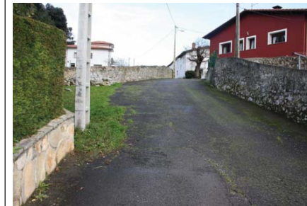
Firme deslizante por vegetación
