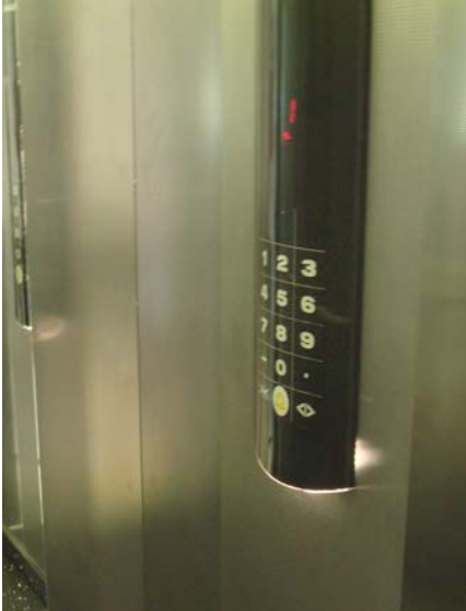
Botonera táctil de ascensor no accesible para personas con discapacidad visual
