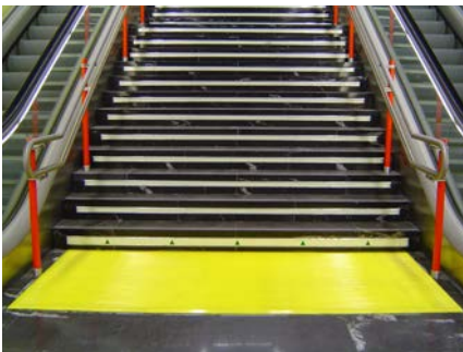
Ejemplo de franja de pavimento de color y textura distinta en el principio de la escalera
