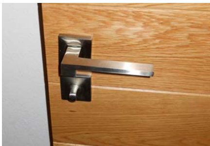
Ejemplo de manilla fácil de manipular y de color contrastado respecto a la puerta
