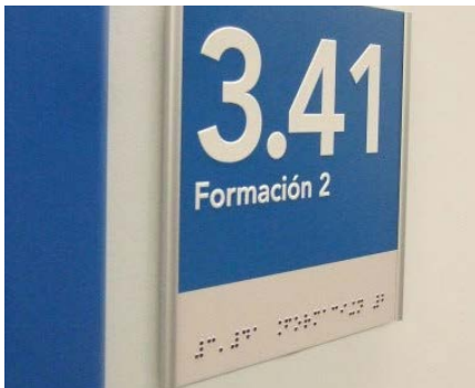
Ejemplo de rótulo de señalización con textos de color contrastado en altorrelieve y complementados en braille
