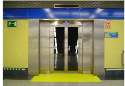
Señalización del número de planta en braille y en alto-relieve. Franja de señalización frente a puerta de ascensor con pavimento de color contrastado y con textura de acanaladura homologada
