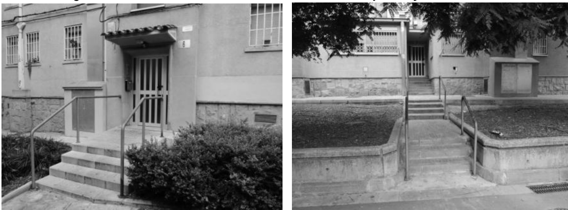
Figura 5. Vista de las escaleras de acceso los bloques 8 y 39 del barrio
