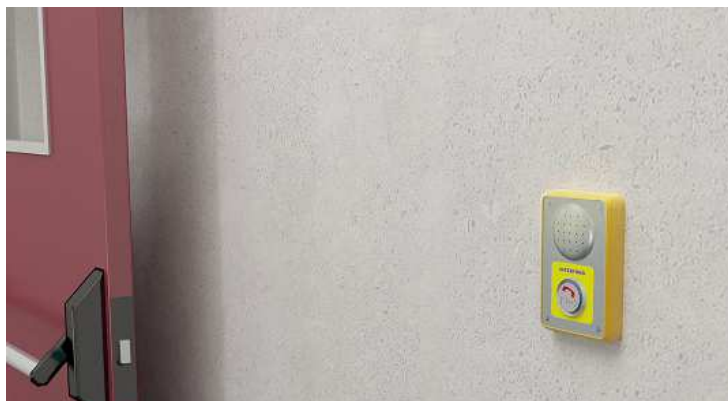
Intercomunicador visual y auditivo conectado con puesto de control. Fuente: Junta de Andalucía 14 .
