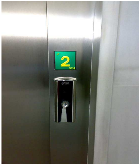
Pulsador de llamada del ascensor.
