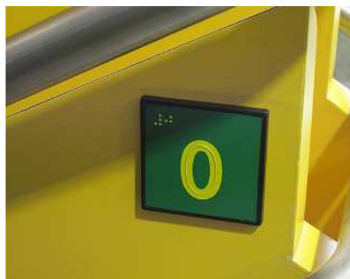
Señalización en altorrelieve y en braille como información de planta de escaleras.
