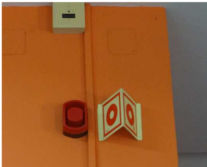
Sistema de megafonía. Correctamente señalado.
