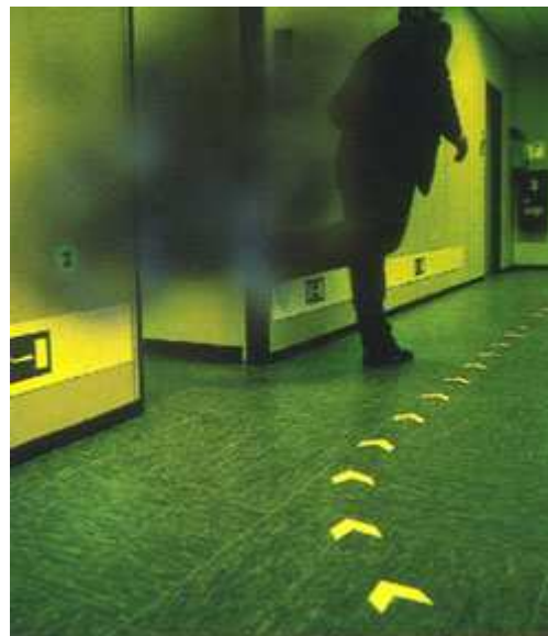
Ejemplo de señales fotoluminiscentes y de balizamientos fotoluminiscentes. Fuente: señales de seguridad SIN.
