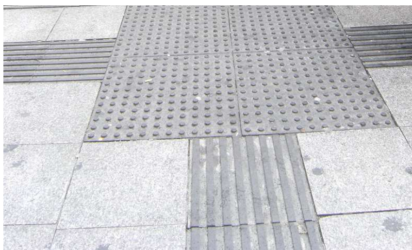
Cruce de dos bandas de encaminamiento. El cruce entre ambas se realiza con pavimento táctil de botones.
