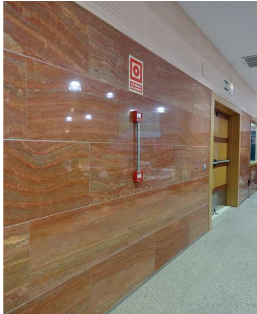
Pulsador situado entre 0,80 y 1,20 m de altura.
