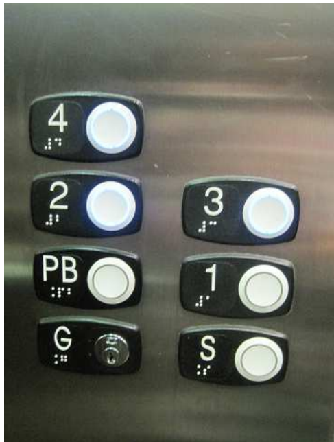
Detalle de botonera de ascensor con números en alto relieve y braille, y de botón con señalización luminosa al ser pulsado.
