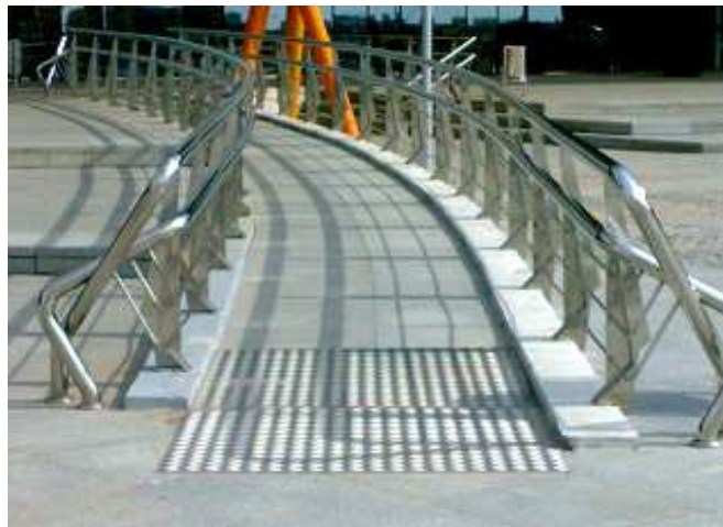
Detalle de rampa con zócalo de obra de 10 centímetros de altura.
