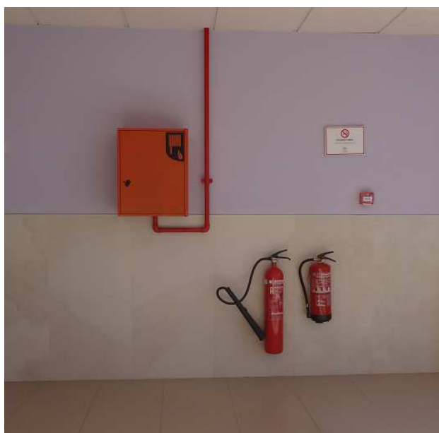
Extintores situados a baja altura y Bie.
