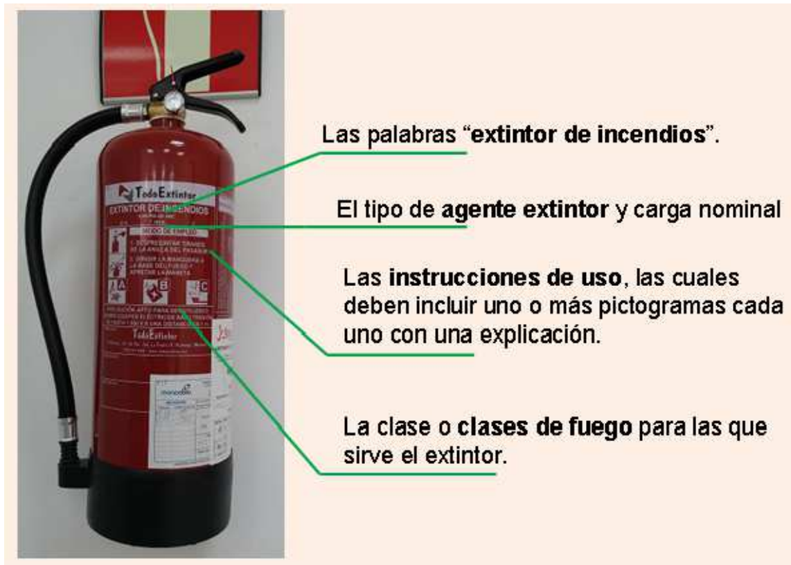
Información que debe aparecer en el extintor
