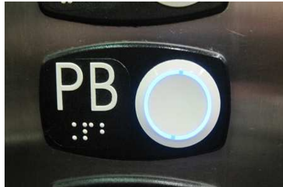
Detalle de botonera de ascensor con números en alto relieve y braille, y de botón con señalización luminosa al ser pulsado.
