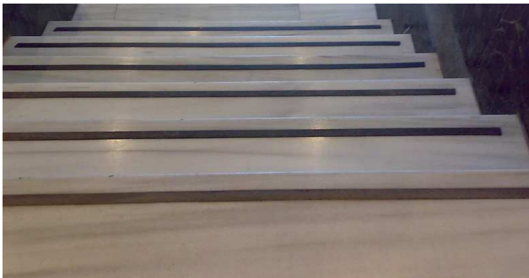
Detalle de peldaño con banda de señalización enrasada en la huella.
