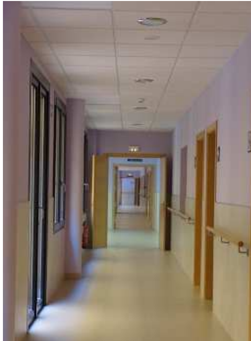
Pasillo con luminarias alineadas.
