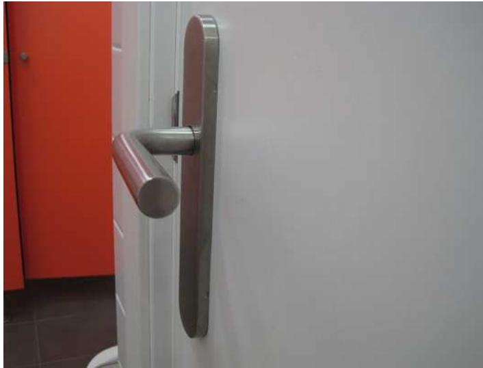
Maneta accionable por una sola mano, buen contraste cromático y separación entre esta y la hoja.
