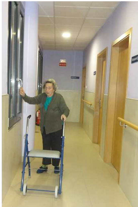
Ventana con maneta a 1,20 m de altura.
