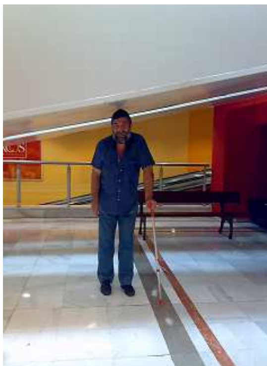
Espacio bajo la rampa inferior a 220 centímetros. Da lugar a golpes en la cabeza.
