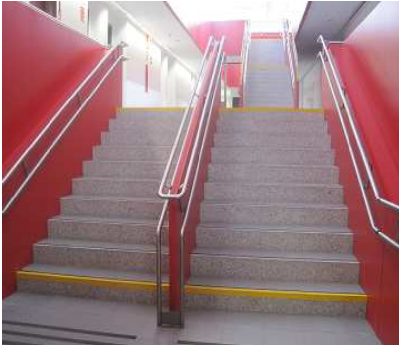
Detalle de doble pasamanos en escaleras.
