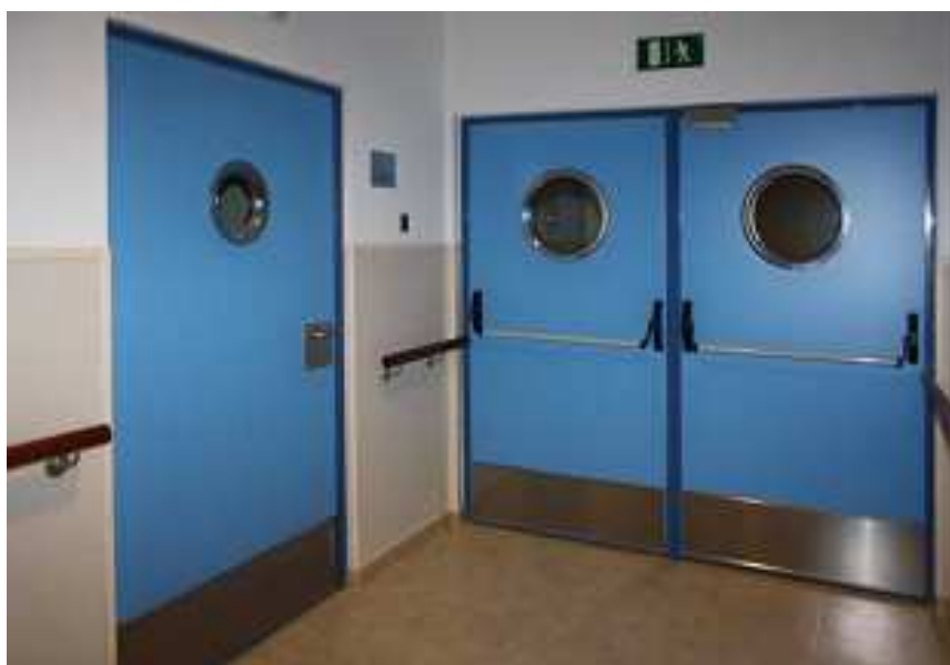
Puertas cortafuegos con elementos transparentes y contrastadas con el paramento. Fuente: www.andreu.es
