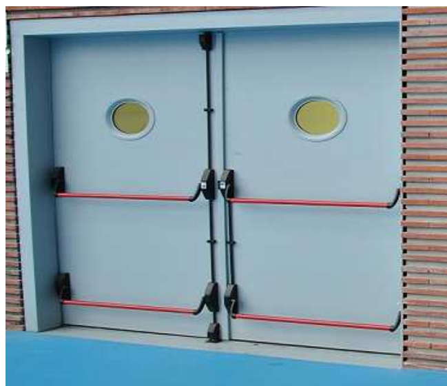
Detalle de puerta cortafuego con dos barras antipánico.
