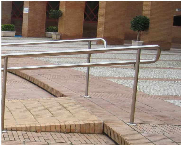
Remate de los pasamanos en rampa. Se prolonga 30 centímetros y se une el pasamanos superior con el inferior formando curva.
