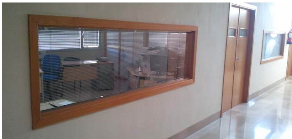
Imagen 15. Colocación de vidrios en tabiquerías. Sede de la Fundación Andaluza Accesibilidad y Personas Sordas de Granada. / Elaboración propia.
