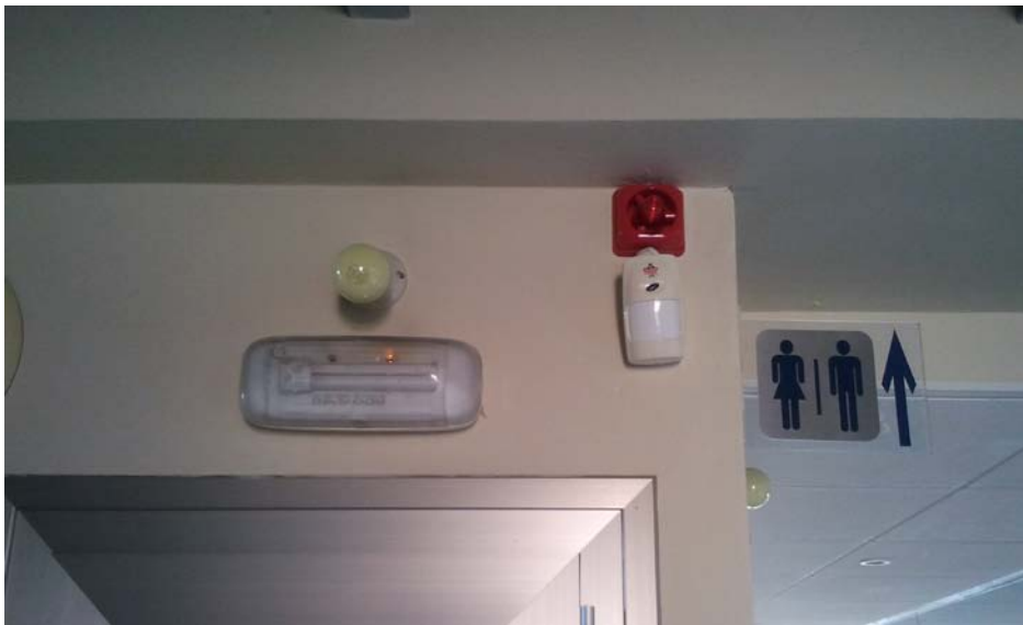
Imagen 34. Aviso luminoso de alarma en la sede de la Fundación Andaluza Accesibilidad y Personas Sordas de Granada./ Elaboración propia.
