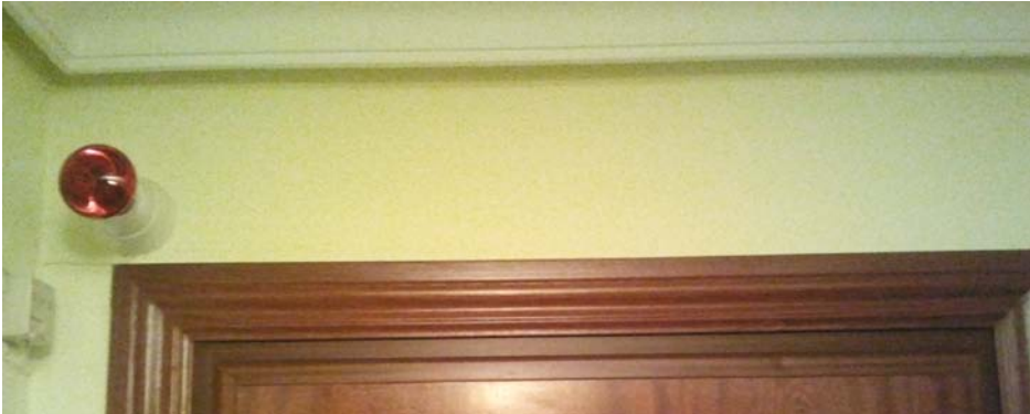
Imagen 39. . Avisado luminoso de timbre./ Elaboración propia.
