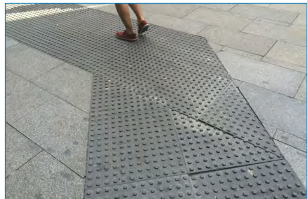
Figura 60. Tramo de acera calle de Madrid. / Fuente propia.
