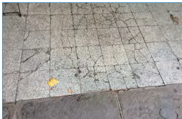
Figura 54. Tramo acera calle en Olot, Gerona./ Fuente propia.
