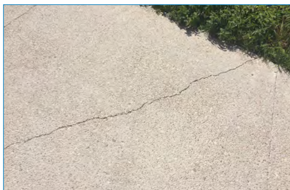
Figura 43. Acceso calle peatonal UAM. China lavada "in situ"./ Fuente propia.
