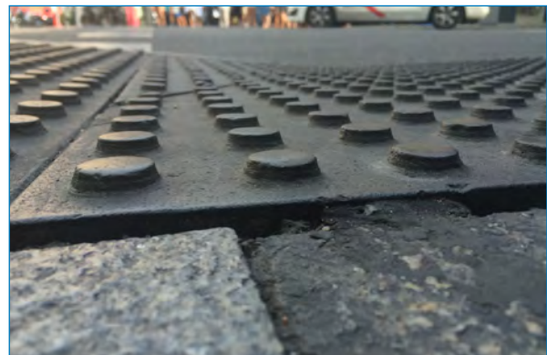
Figura 61. Tramo de acera calle de Madrid. / Fuente propia.
