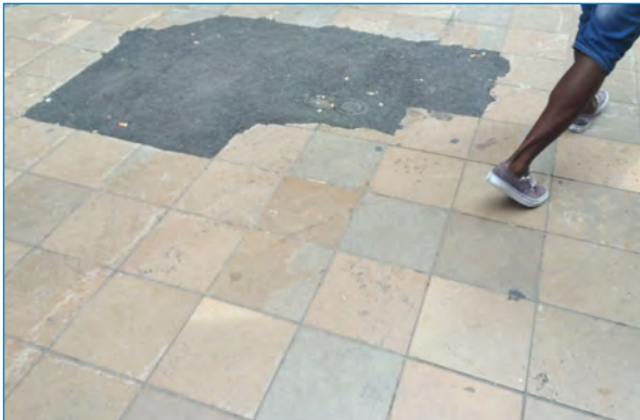
Figura 46. Plataforma mixta. Bordeaux, Francia./ Fuente propia.
