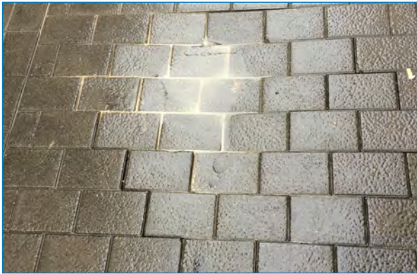
Figura 56. Tramo acera calle en Olot, Gerona. / Fuente propia.
