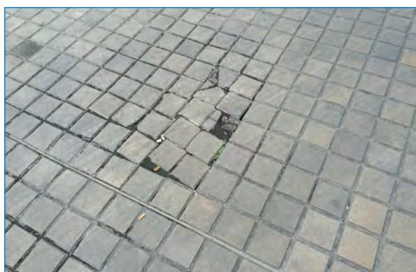
Figura 53. Tramo acera calle en Olot, Gerona./ Fuente propia.
