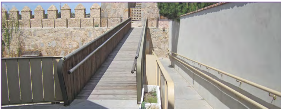
Imagen 113. Rampas accesibles en la Muralla de Ávila.
