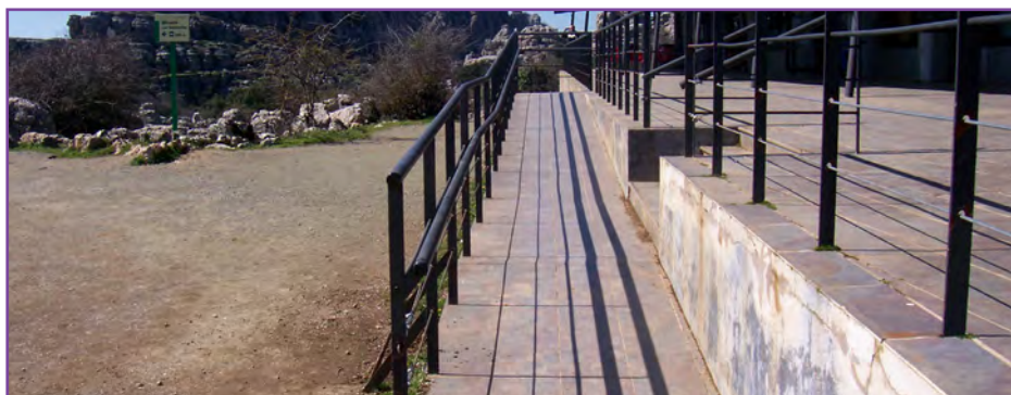
Imagen 112. Rampa de acceso a Centro de Visitantes y atención al público.
