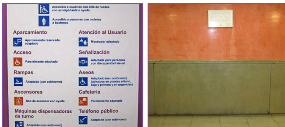
Imágenes 190 y 191. A la izquierda señalización accesible y a la derecha inaccesible.
