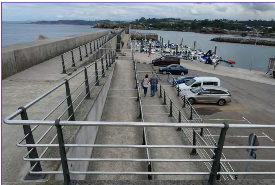
Imagen 115. Rampa accesible para salvar desnivel de una planta de altura.
