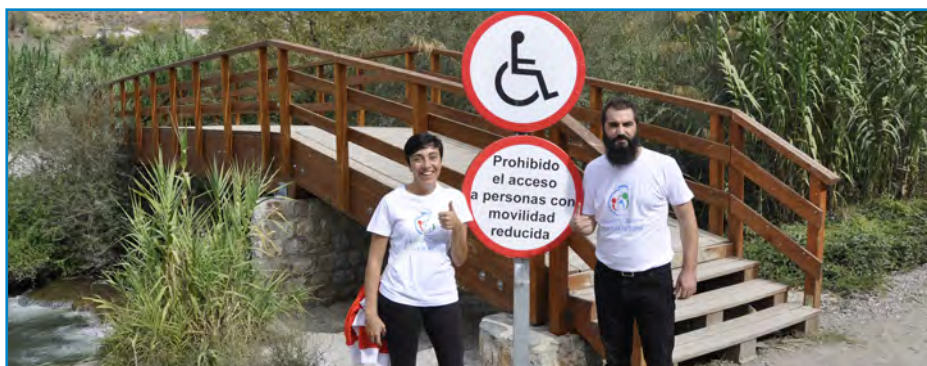
Imagen 50. Puente en el paseo Fuente de la Bicha inaccesible.
