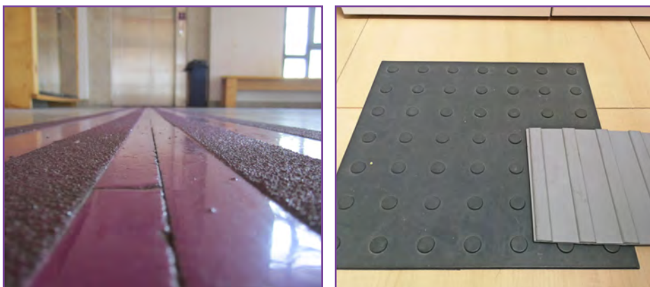
Imágenes 137 y 138. Ejemplos de pavimento táctil direccional y de advertencia.
