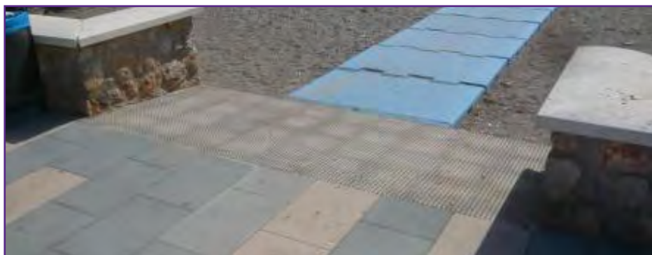
Imagen 64. Acceso practicable desde el paseo marítimo. / Junta de Andalucía.
