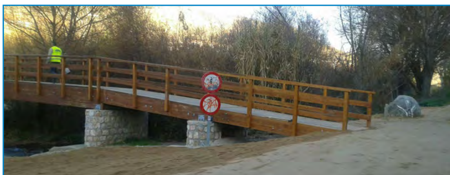
Imagen 51. Puente en el paseo Fuente de la Bicha accesible.
