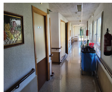
Figura 9. Fotografía pasillo CAMF Pozoblanco
