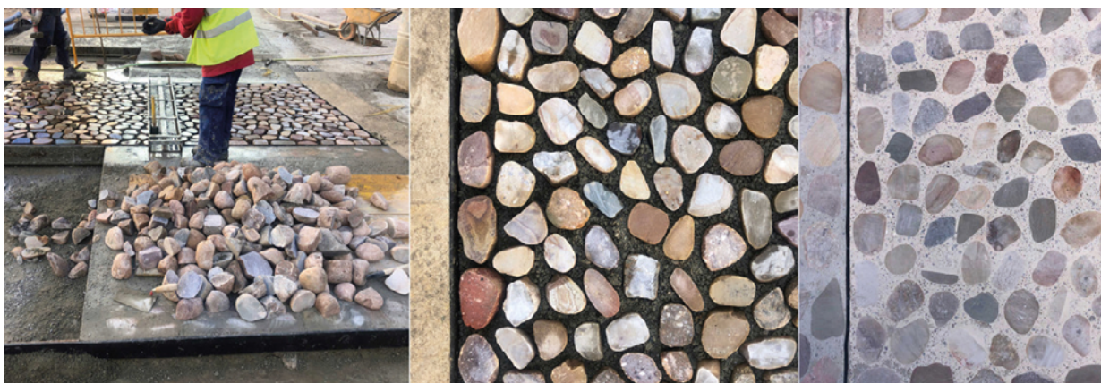
Imágenes del proceso de ejecución del empedrado tradicional recuperado
