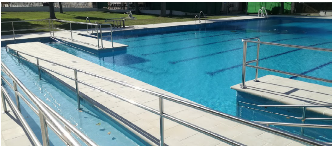
Imagen de la piscina después del llenado
