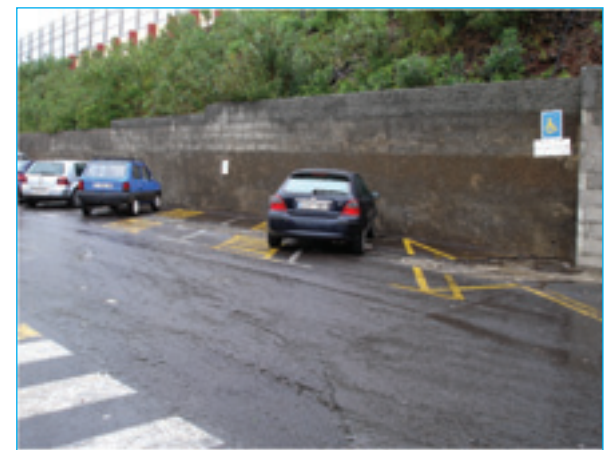
FOTOS 16, 17 Y 18 : ENTRADA PRINCIPAL PISCINA CUBIERTA MUNICIPAL "BALTAVIDA", BAÑOS ADAPTADOS, ACCESO A PISCINA Y ESTACIONAMIENTO RESERVADO
