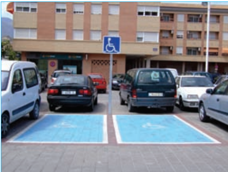
APARCAMIENTO Y RAMPA DE ACCESO AL AYUNTAMIENTO
