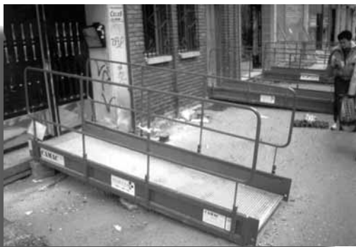
Solución de pasarelas utilizando andamios metálicos colgantes empleados normalmente en la ejecución de fachadas.
