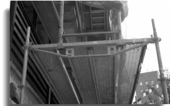
Otro ejemplo de viga en andamio multidireccional.
