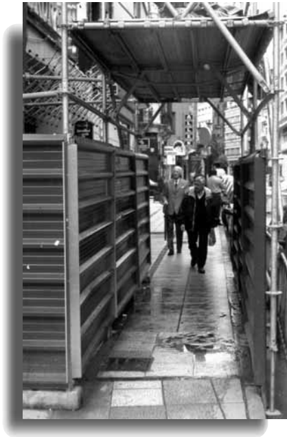
Paso protegido en el exterior de la acera.
