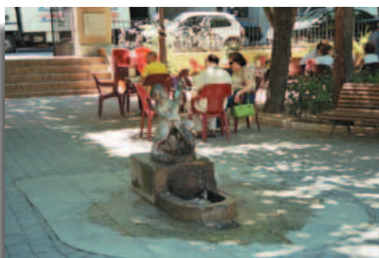
Detalle de fuente para beber, rehabilitada a fin de hacerla accesible. Parque de San Julián. Cuenca.
