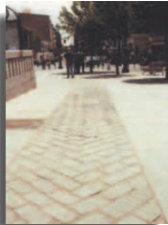
Encaminamientos en la Plaza de Lavapiés. Madrid.
