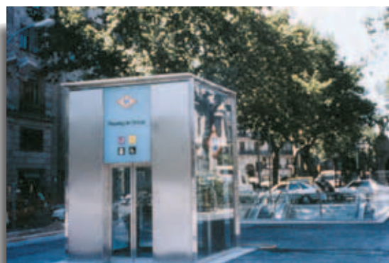
Ascensor del metro de Barcelona.
