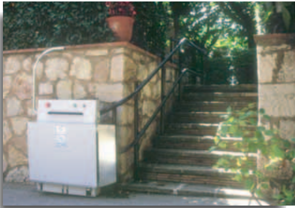
Fig. 14 y 15. Salvaescaleras y plataformas que no interfieren con el recorrido peatonal. Cuando están inactivos ofrecen mejores condiciones de seguridad. Una colocación como la que aparece en la fig. 16 reduce el ancho útil de la escalera y obstaculiza la circulación peatonal próxima al edificio.
