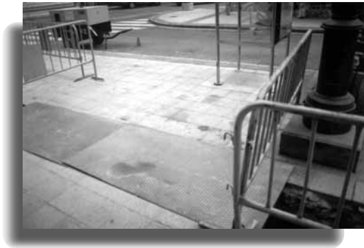
Empleo de chapas metálicas en paso de zanja.
