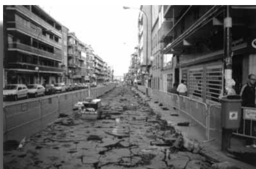
Zona de trabajos protegida en todo su perímetro con vallas móviles.
