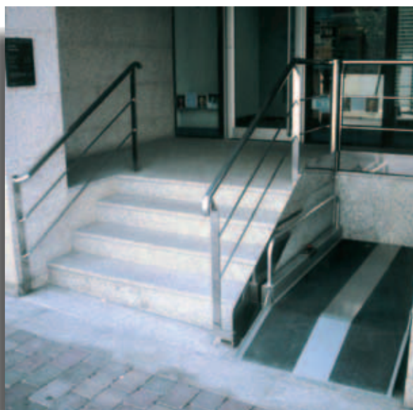
Fig. 30. Ejemplo de plataforma elevadora mecánica utilizada para salvar una escalera de acceso.
