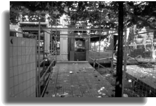
Una gran plataforma salva la zona de trabajos, desarrollándose un pasillo de tabloncillos de madera para dar acceso a portales y locales comerciales.
