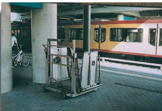
Detalle de plataforma elevadora en andén.
