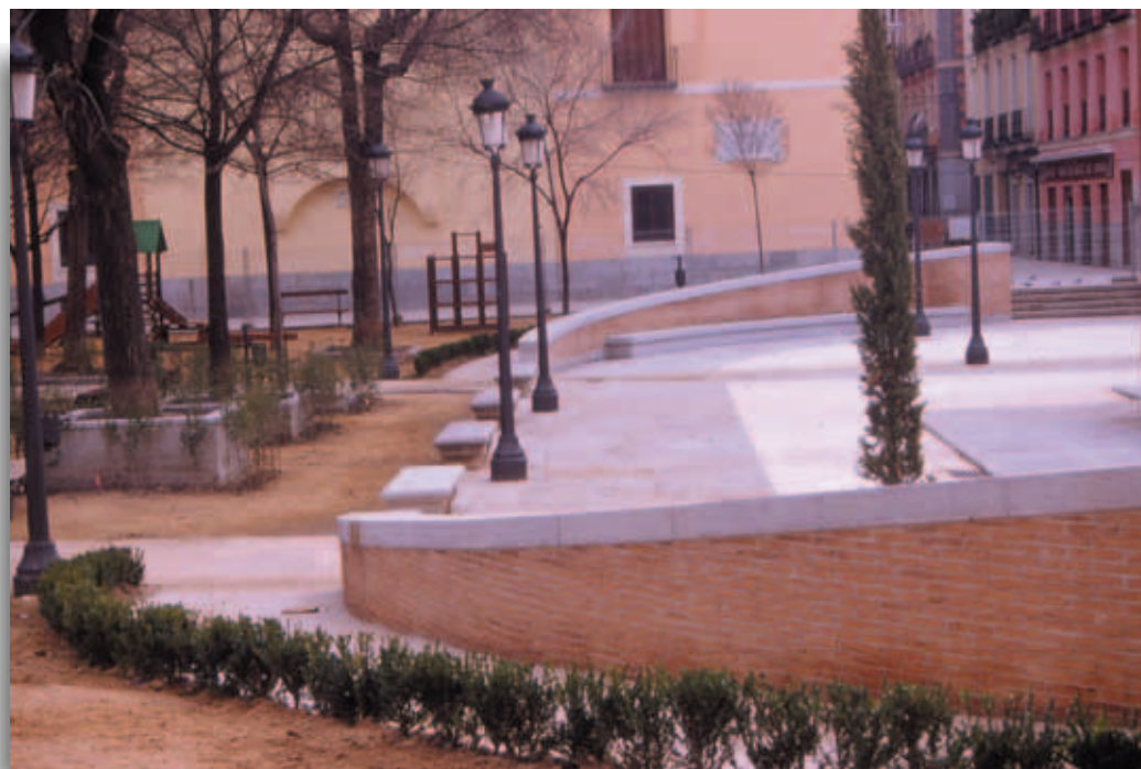
Rehabilitación de la Plaza Dos de Mayo. Madrid. Rampa de acceso a la plaza.
