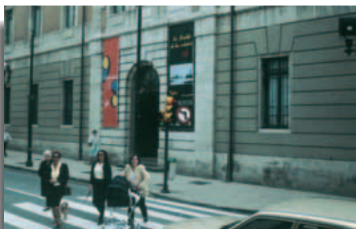
Fig. 23. Muchas veces no es posible la disposición de un rampa en la entrada principal del edificio. Centro de Cultura Antiguo Instituto Jovellanos, Gijón.
