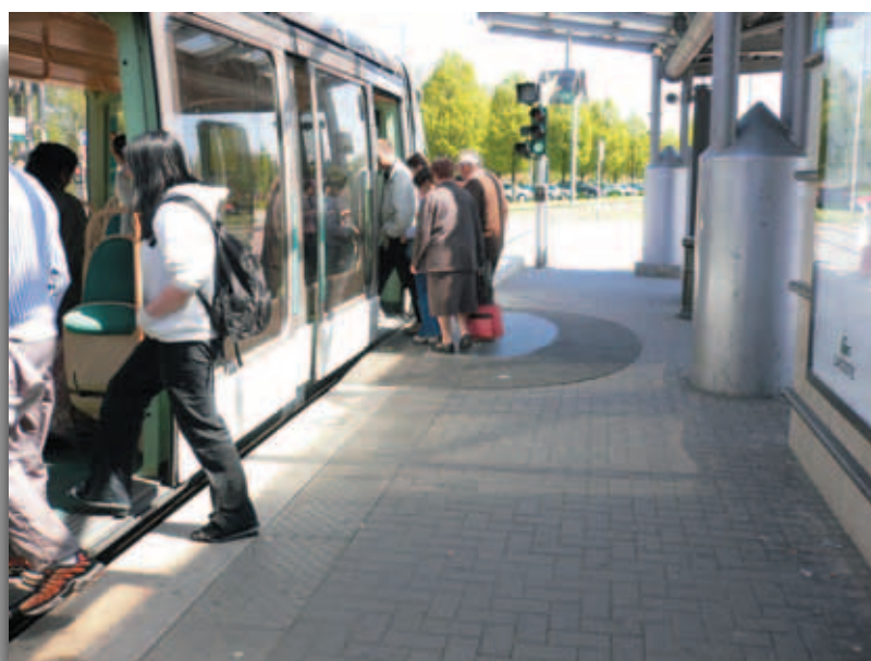
Tranvía de Estrasburgo. Señalización en pavimento de la puerta de embarque para personas de movilidad reducida.
