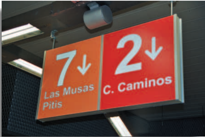
Detalle señalización vertical vestíbulo. Metro de Madrid.
