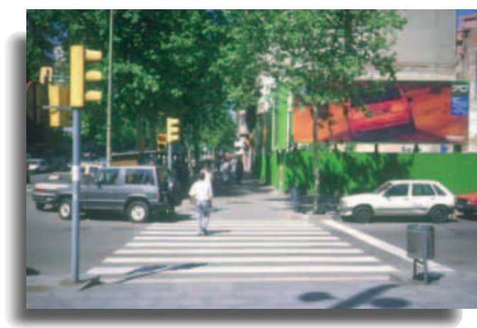
Fig. 1, 2, 3 y 4. La resolución con elementos urbanos accesibles y normalizados del cruce de circulaciones peatonales y vehiculares en el entorno urbano ha experimentado un gran avance en los últimos años. El ejemplo presenta una gama de vados para vehículos compuesto por piezas normalizadas de 20, 40 y 60 cm. de ancho (según altura y amplitud de la acera) que respetan la continuidad del recorrido peatonal y el vado peatonal de 120 cm., que integra papeleras y semáforo como elementos de uso, delimitación del paso peatonal y protección del desnivel lateral, incorpora una franja central perpendicular como encaminamiento para invidentes, utiliza material fácil de mantener y antideslizante (granito abujardado) y ofrece piezas especiales para encuentros curvos.
