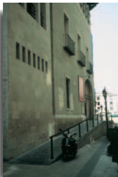
Fig. 21. Rampa y escaleras dispuestas en el exterior. Palacio Marqueses de Montemuzo, Zaragoza.
