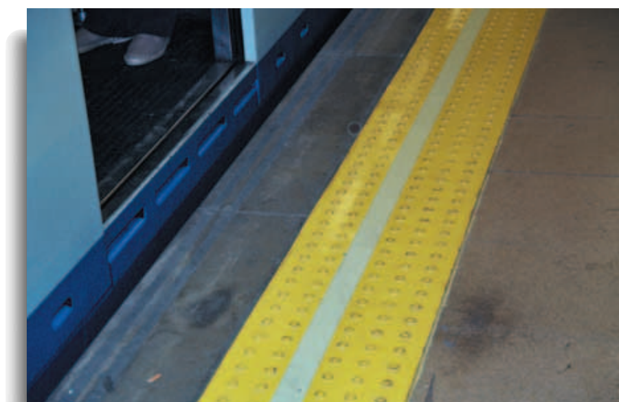
Franja de señalización y seguridad al borde del andén. Metro de Madrid.
