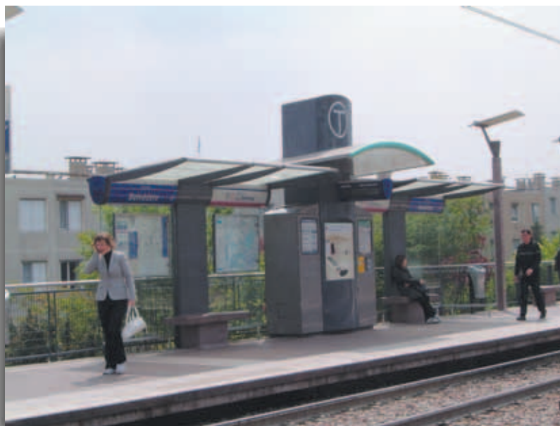
Tranvía de París. Marquesina dotada con toda la señalización informativa necesaria.
