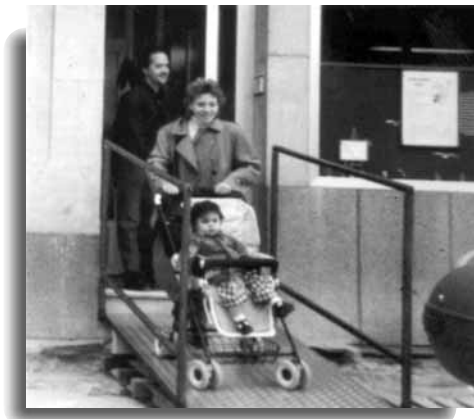
Pasarela de peatones utilizada durante los trabajos de rehabilitación de una calle.
