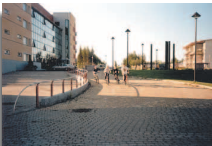
Senda peatonal con pavimento con textura diferenciada. Joensuu. Finlandia.
