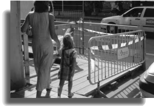
Acera provisional ejecutada con tabloncillos de madera.
