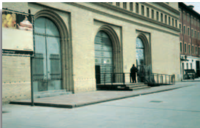
Fig. 22. Ejemplo de estructura independiente para facilitar el acceso. Lonja de Mercaderes, Zaragoza.
