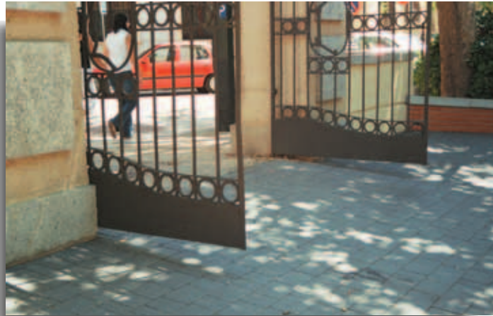
Detalle de puerta de acceso. La accesibilidad está garantizada.
