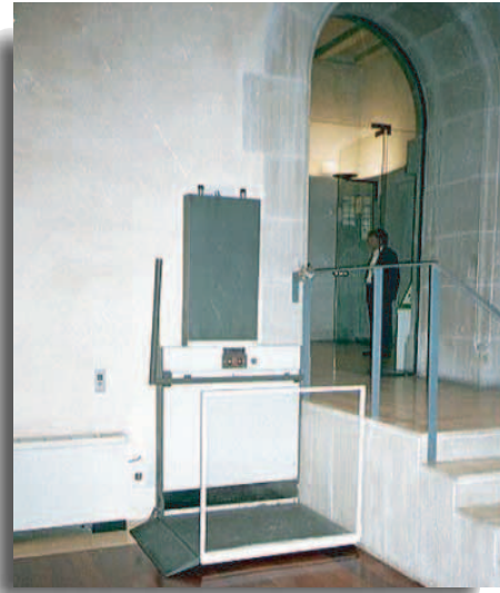
Fig. 14 y 15. Salvaescaleras y plataformas que no interfieren con el recorrido peatonal. Cuando están inactivos ofrecen mejores condiciones de seguridad. Una colocación como la que aparece en la fig. 16 reduce el ancho útil de la escalera y obstaculiza la circulación peatonal próxima al edificio.
