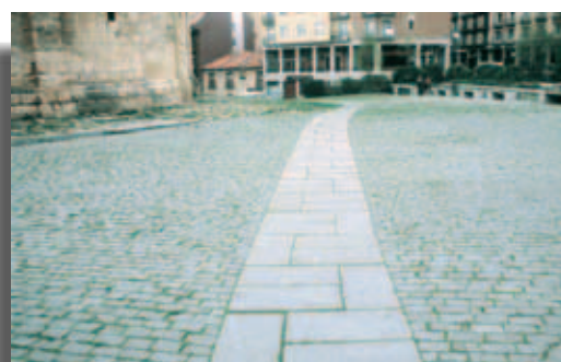
Fig. 7. Detalle de la solución anterior: la accesibilidad se consigue sin renunciar al uso de pavimentos tradicionales.
