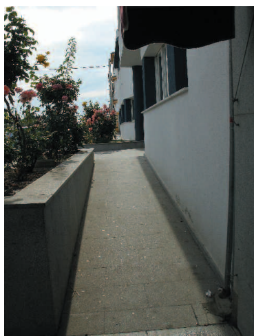
Rampa de acceso al Centro Andaluz de Alzheimer
