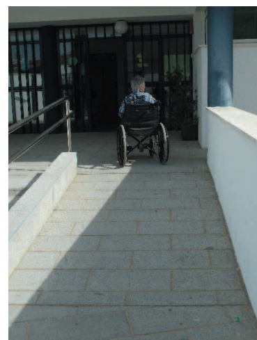
Rampa de acceso a la Unidad Psico geriátrica
