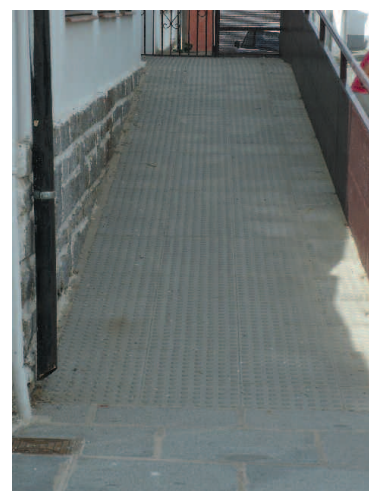
Rampa de acceso a la Escuela Infantil
