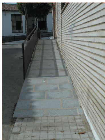
Rampa de acceso al Salón de Convivencia
