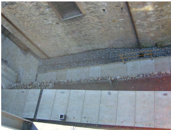
Arranque de rampas (obras).
