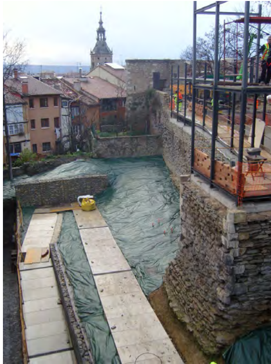
Rampas y muralla (obras).
