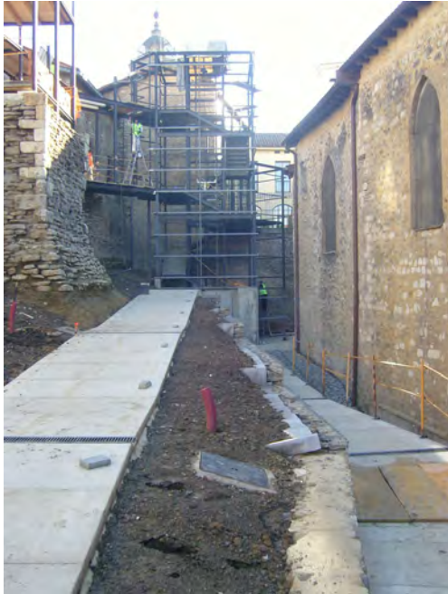
Rampas y estructura del ascensor (obras).
