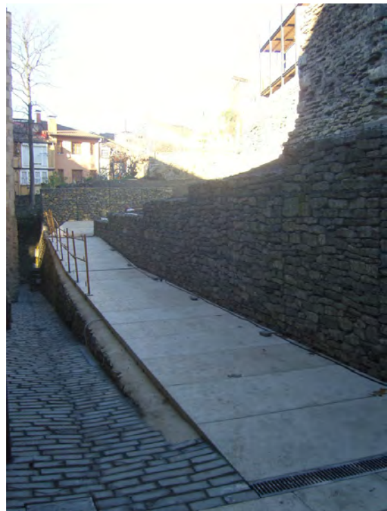
Rampas en borde de muralla (obras).
