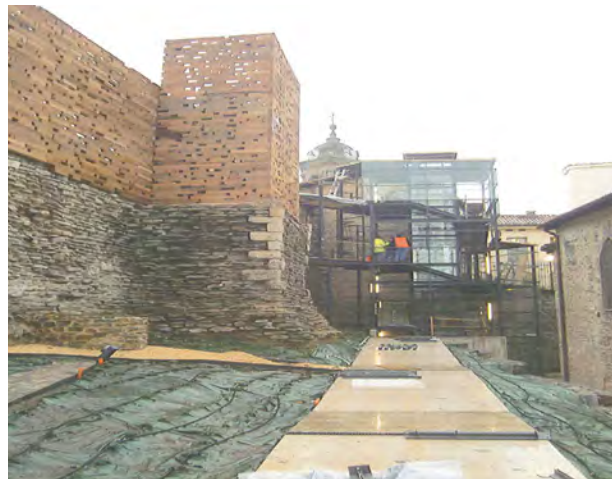
Rampas y estructura del ascensor (obras).
