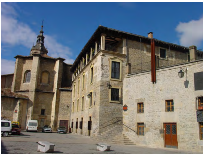
Edificación: adecuación Palacio Villasuso, prevista para 2012.
