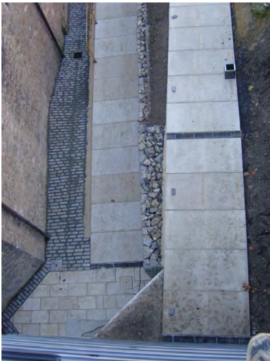
Vista de rampas desde el ascensor (obras).
