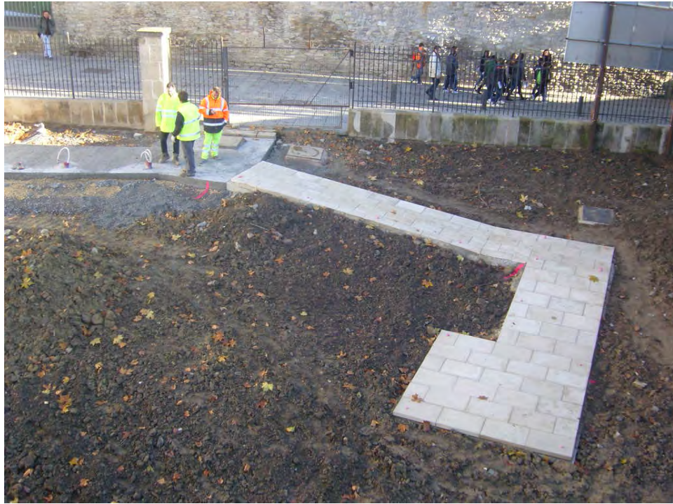
Acceso desde calle Fray Zacarías (obras).
