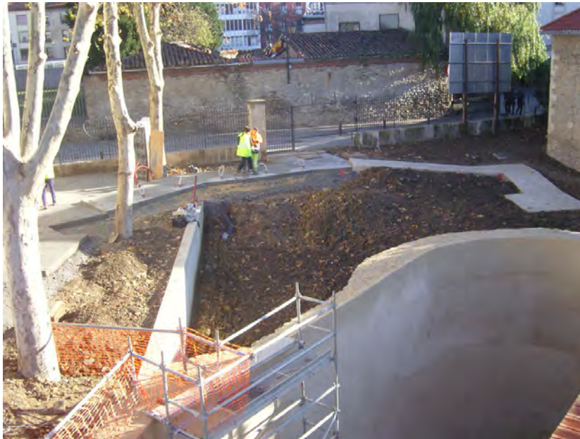
Las Neveras (obras).
