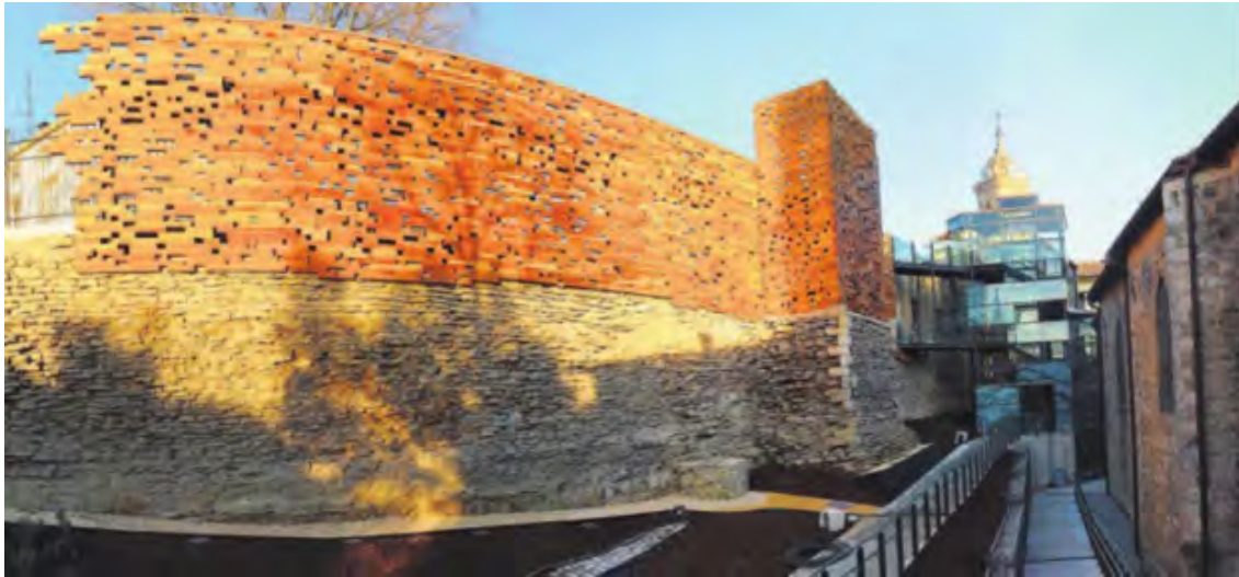
Rampas y estructura del ascensor (estado actual, 2011).
