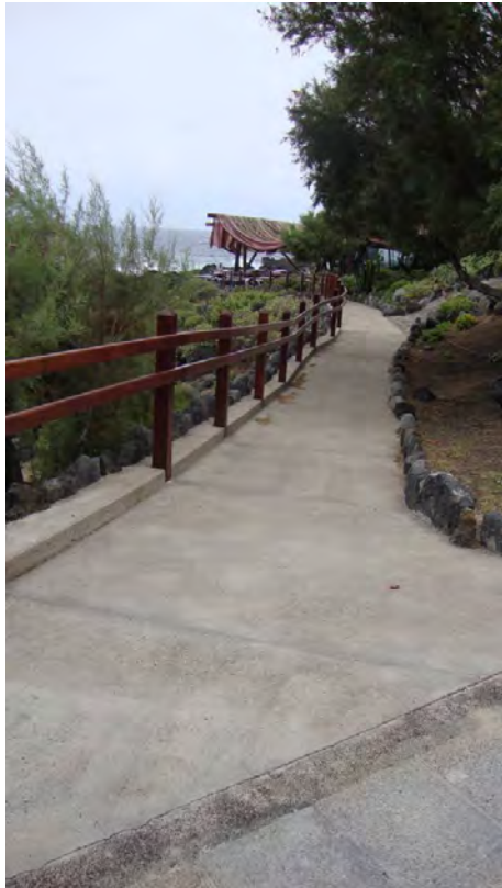
Rampa de acceso peatonales "Punta Negra".
