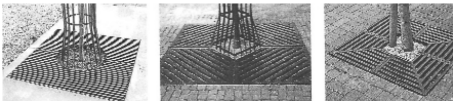
Figura 23: Ejemplos de alcorques protegidos con rejillas metálicas.
