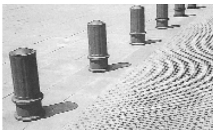
Figura 22: Bolardos que limitan la calzada de la acera para peatones.
