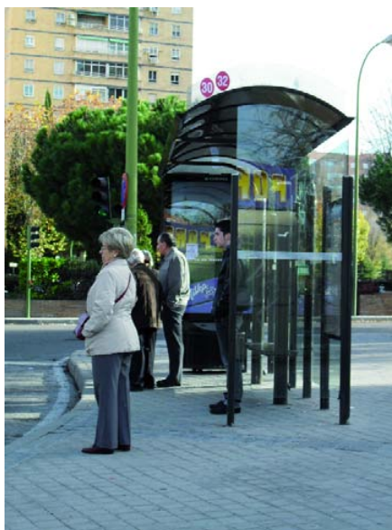
Figura 55: Marquesina con espacio de acceso adecuado para usuarios de silla de ruedas.
