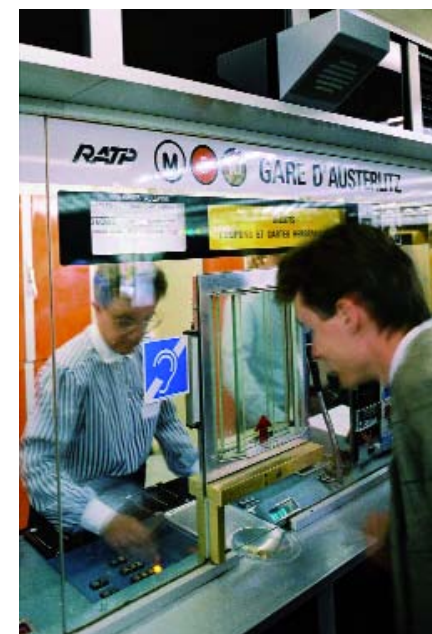
Figura 45: Taquilla del Metro de París equipada con bucle de inducción magnética, señalizado con el icono correspondiente.
