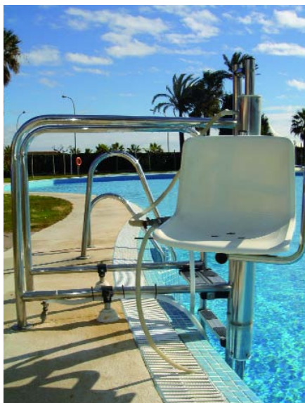
Figura 40: Grúa para entrar al vaso de la piscina.
