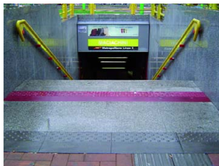
Figuras 9 y 10: Ejemplo de franja de pavimento de color y textura distinta en el principio de la escalera. Metro de Madrid y Metro de Milán.
