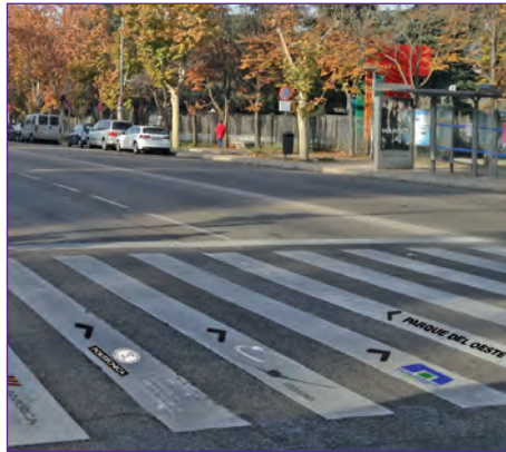
Imagen 33. Colocación de mensajes en el pavimento./ Andrea Márquez Bascón.
