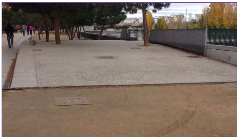
Grupo de imágenes 14. Rampa acceso a pasarela de la playa (km. 5,50)
