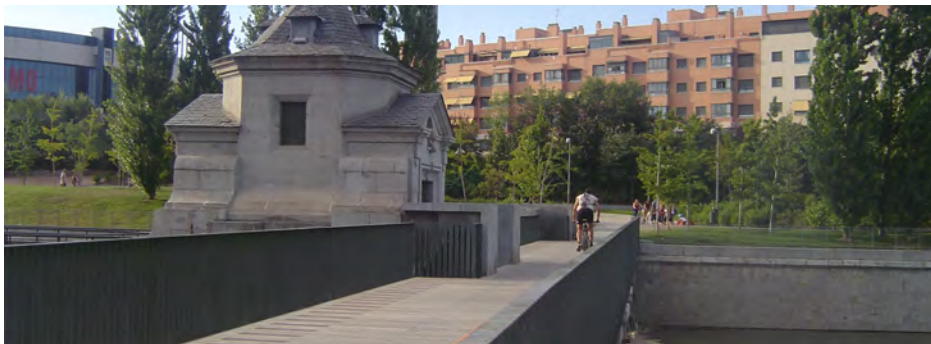
Imagen 75. Puente peatonal sobre el Río Manzanares, Madrid-Río.
