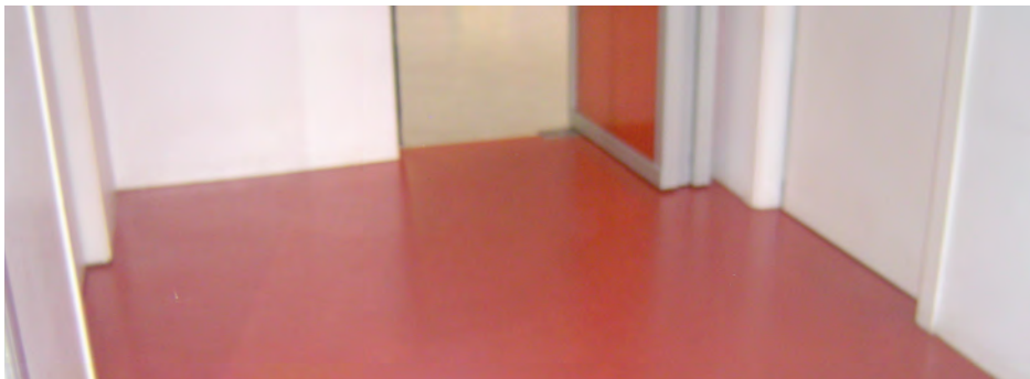
Imagen 80. Suelo antideslizante, entrada a la zona de bebés de la Guardería Las Nanas Alcorcón.
