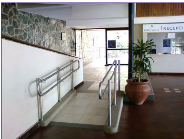
Imagen 13. Desnivel interior resuelto con rampa./ Elaboración propia.
