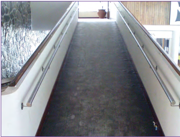
Imagen 15. Instalación de barrales en rampa./ Elaboración propia.
