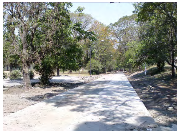
Imagen 7. Calle de acceso. / Elaboración propia.
