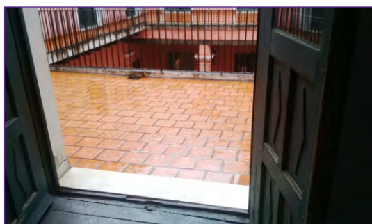
Imagen 21. Entrada a sala planta alta./ Junta de Patrimonio Histórico de la Provincia de Tucuman.
