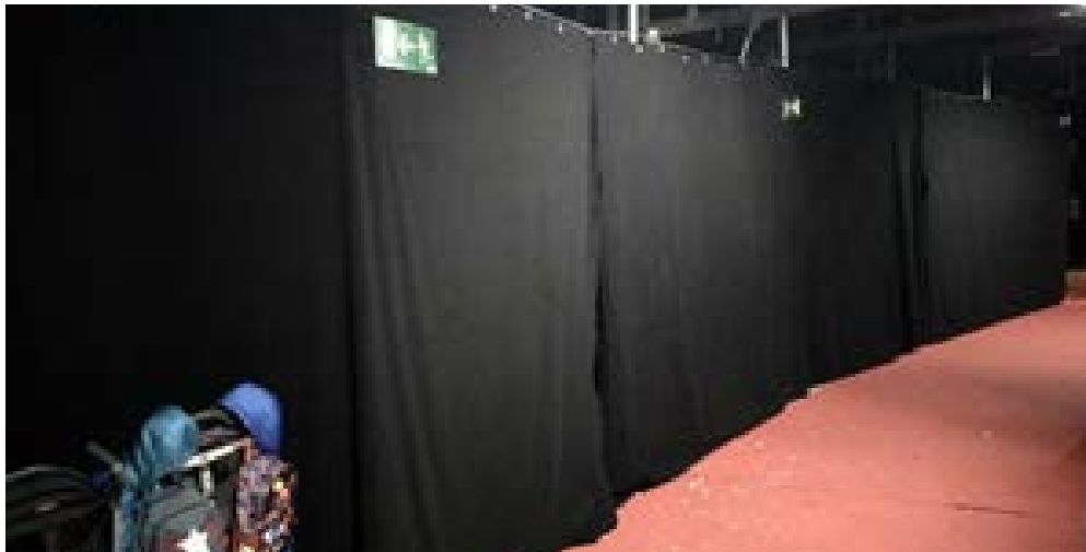
Imagen estructura lateral de cerramiento cubierta
