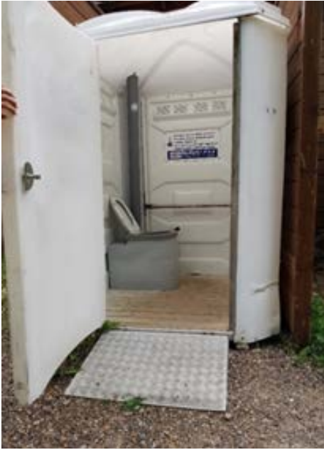
Ejemplo acceso a cabina mediante rampa de excesiva inclinación y que no dispone de espacio horizontal para maniobra y alcance del tirador.
