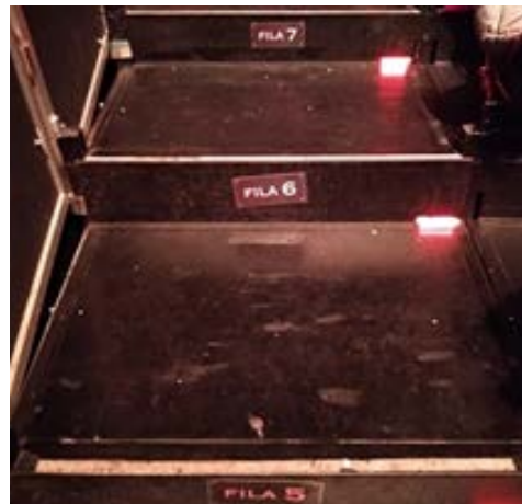
Ejemplos de escaleras adecuadamente protegidas, con huella continua, contrahuella y diferenciación borde de peldaño y tira Led de iluminación en laterales.
