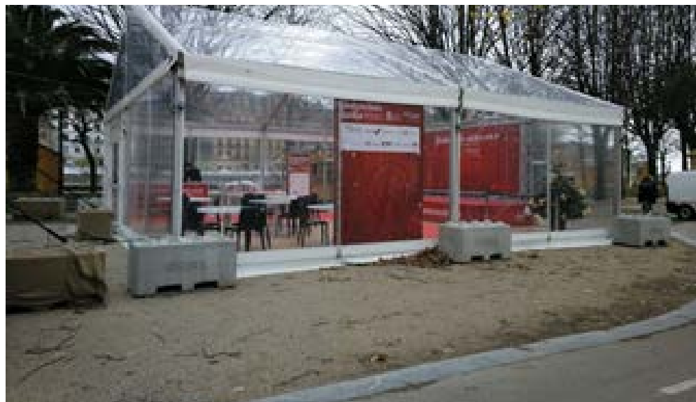
Ejemplo de carpa con cerramiento plástico no detectable
