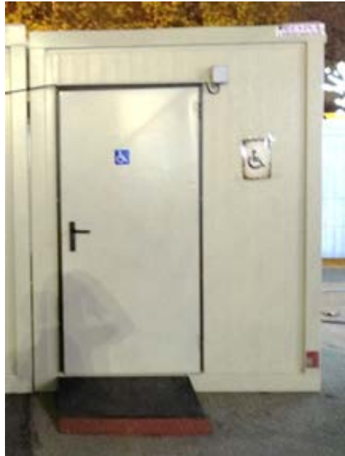
Ejemplo acceso a cabina mediante rampa de excesiva inclinación y que no dispone de espacio horizontal para maniobra y alcance del tirador.
